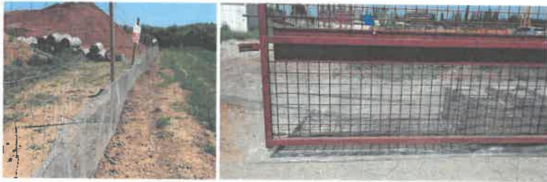
Exemple de système anti-intrusion pour la petite faune : sur une clôture (à gauche) et au niveau d'un portail d'accès au chantier (à droite) – CBE 2018
