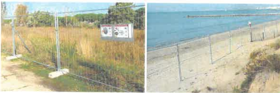
Exemple de mise en défense de secteurs sensibles par barrières de chantier (à gauche) ; clôtures de délimitation d'un chantier, sans système anti-intrusion pour la petite faune (à droite) - CBE 2018
